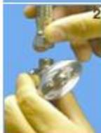
2. Desconecte el tubo de subida de la válvula de suministro de cobre/cromo.
