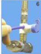
6. Inserte completamente el tubo dentro de la válvula lateral Speedfit®.
