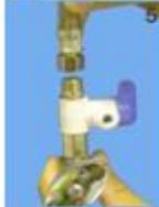
5. Conecte el tubo de subida a la Válvula con Cierre de Paso en T.
